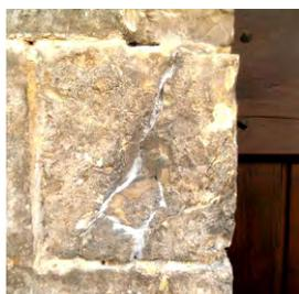
fissaggio delle scaglie con ponticelli in resina acrilica applicata a siringa
