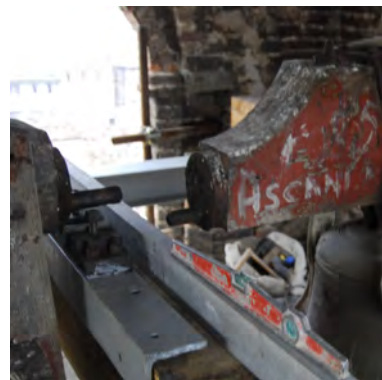
DURANTE LA POSA DEGLI ORGANI IN MOVIMENTO RIGENERATI
