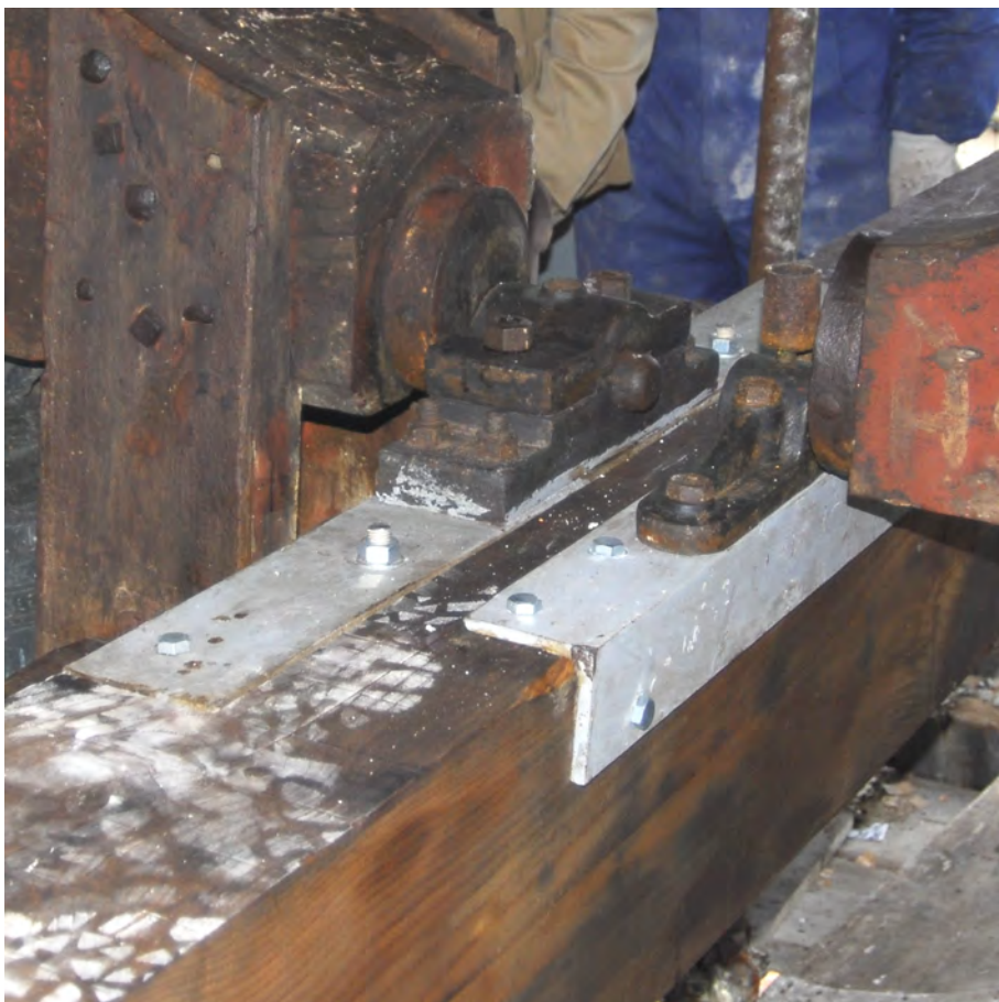
I MECCANISMI RIGENERATI E LE CAMPANE RIPOSIZIONATE
