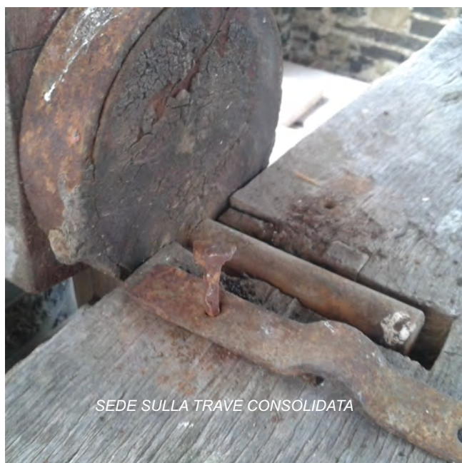
PREPARAZIONE DELLA SEDE PER IL RIPOSIZIONAMENTO DEGLI ORGANI IN MOVIMENTO
