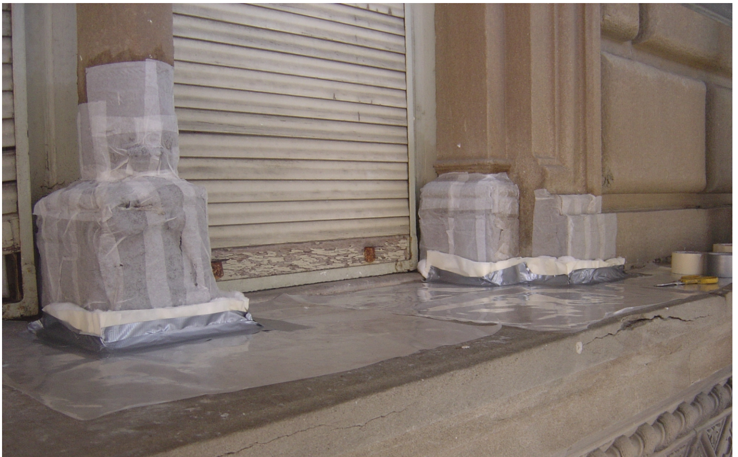
Consolidamento dei basamenti delle bifore del primo livello
