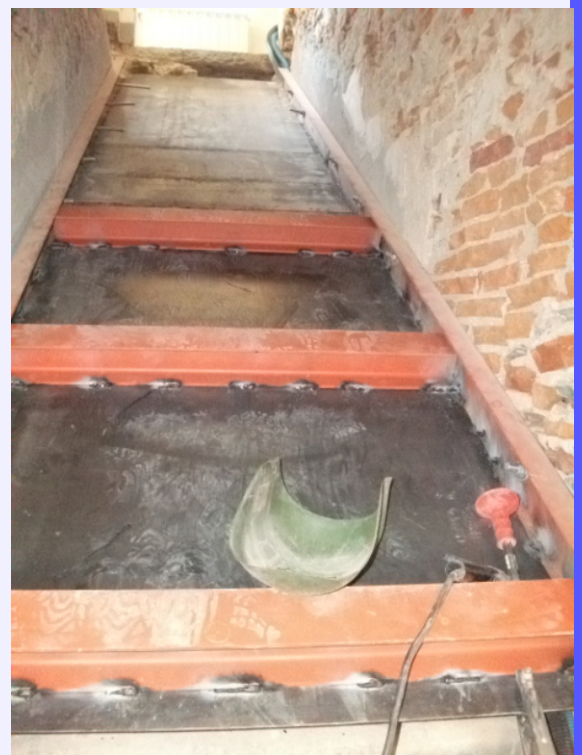
Nuova scala interna 2^ rampa
