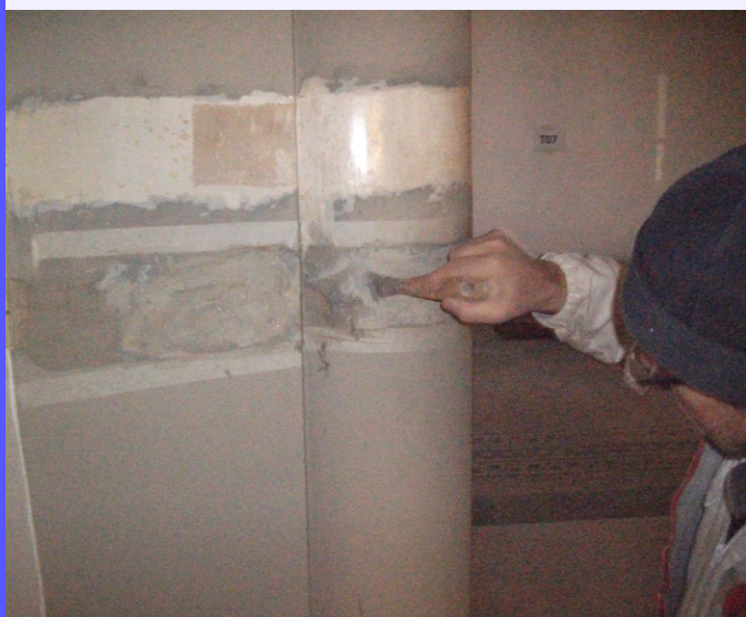
stato di fatto della serliana - dai saggi preliminari si evidenziava il marmorino sottostante fasi di pulitura con impacchi ammorbidenti e raschietti
