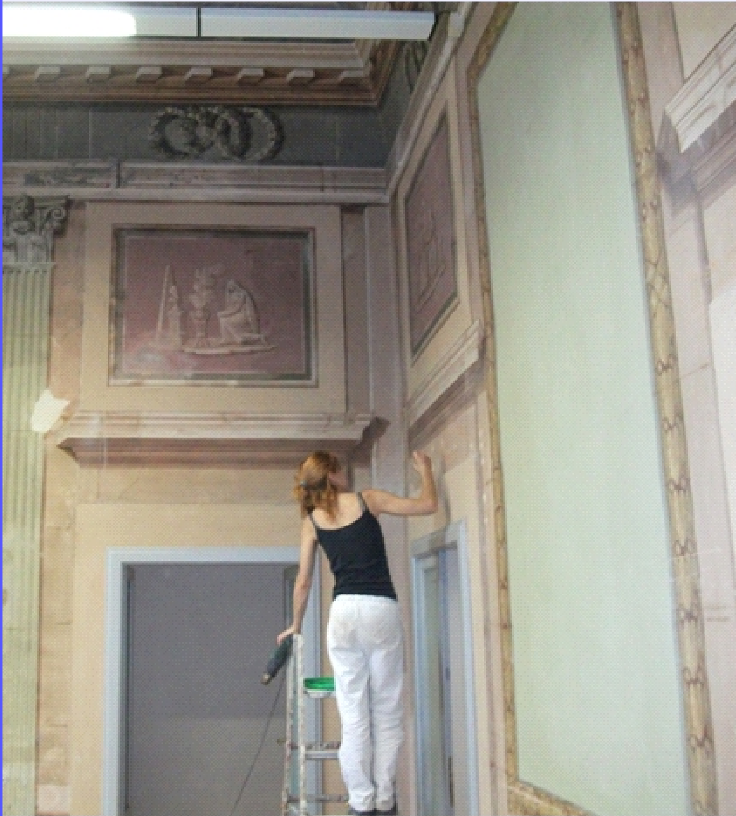
intervento di ripresa di lesioni sulla superficie dipinta del locale T03 con consolidamento localizzato di alcuni distacchi d'intonaco
