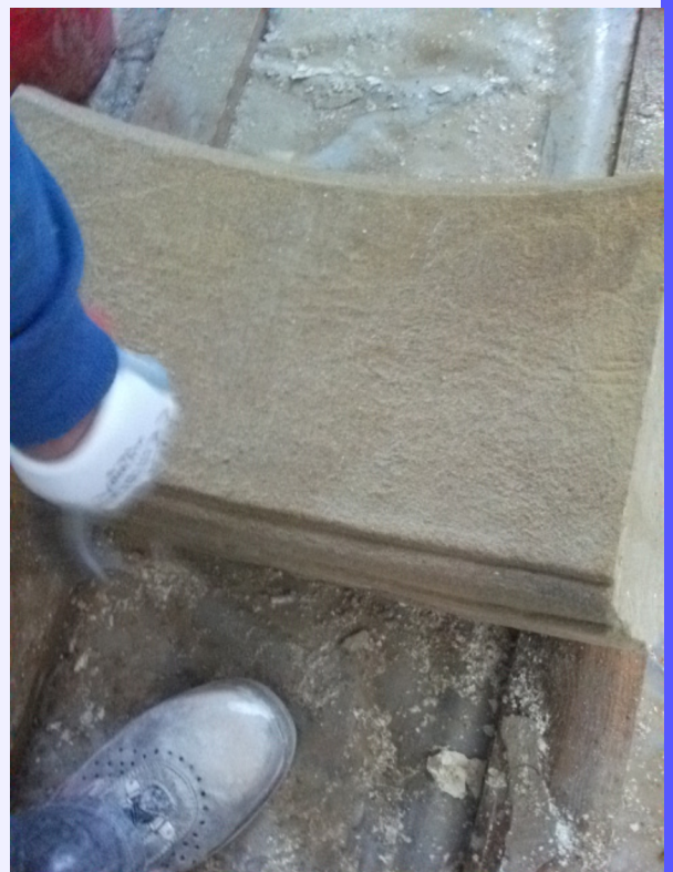
pulizia degli elementi in pietra
