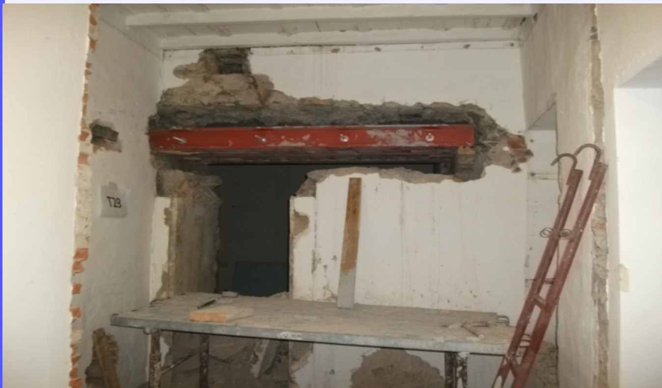
Creazione nuovo passaggio interno loc T29 T27
