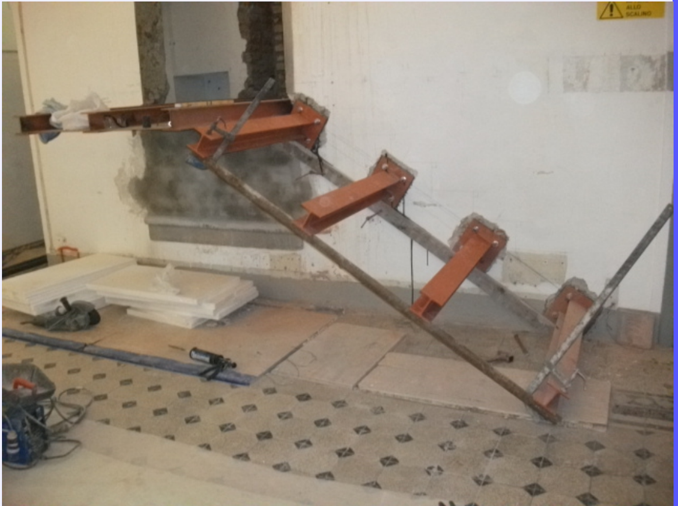
nuova scala interna 1^ rampa su loc T33
