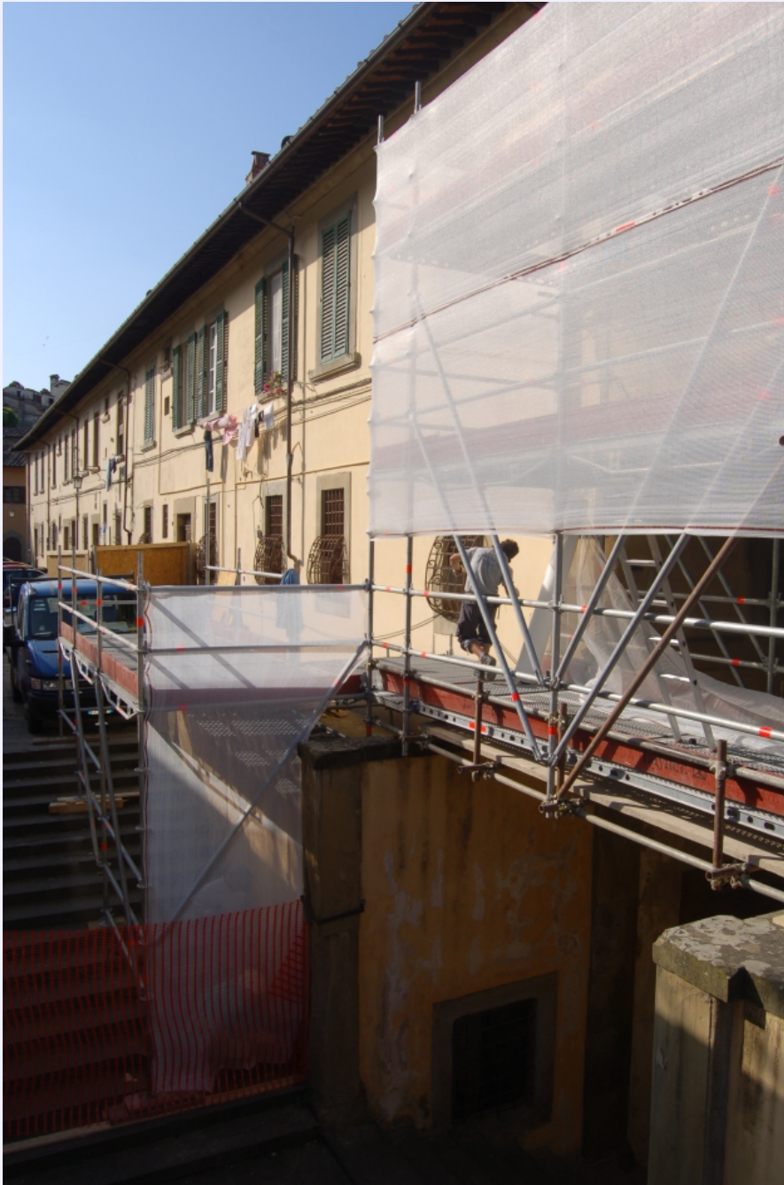
Fase di allestimento del cantiere Con predisposizione dei passaggi
