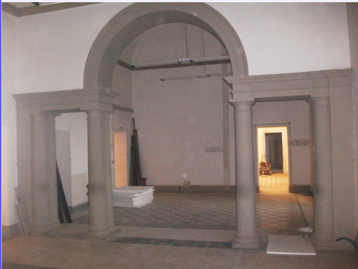
stato di fatto della serliana - dai saggi preliminari si evidenziava il marmorino sottostante fasi di pulitura con impacchi ammorbidenti e raschietti
