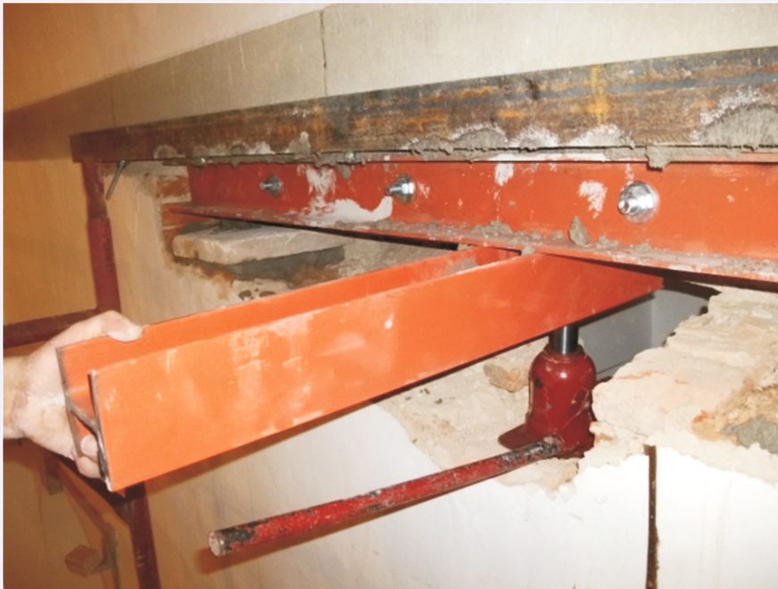
Inserimento di architrave in acciaio su alloggiamento creato ed accostamento meccanico alla struttura provvisoria e provvisoriale
