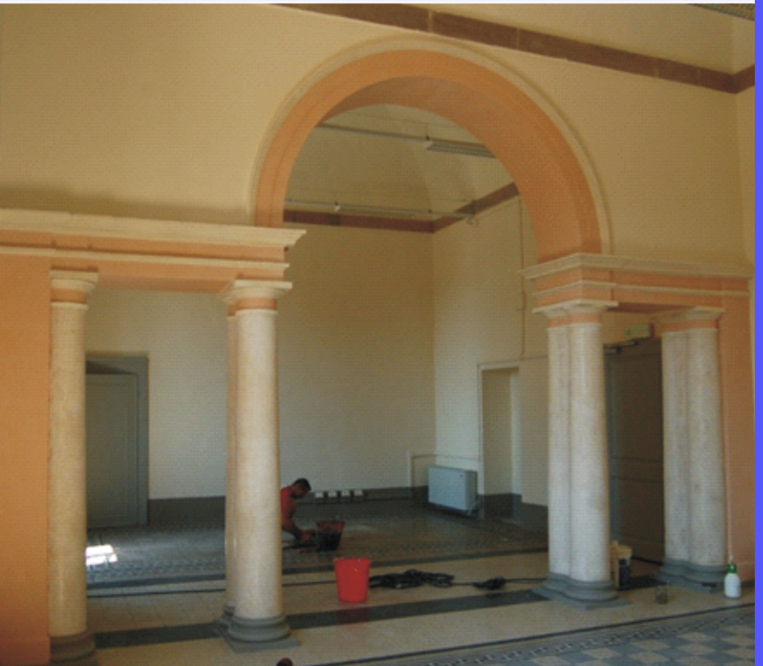
vista finale dell'intervento
