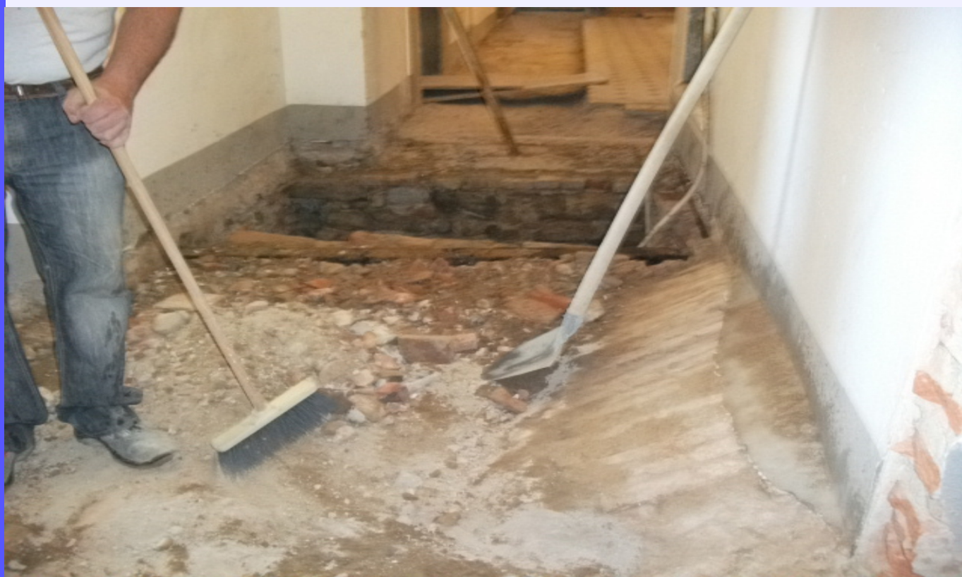
Svuotamento volta loc T29 T30
