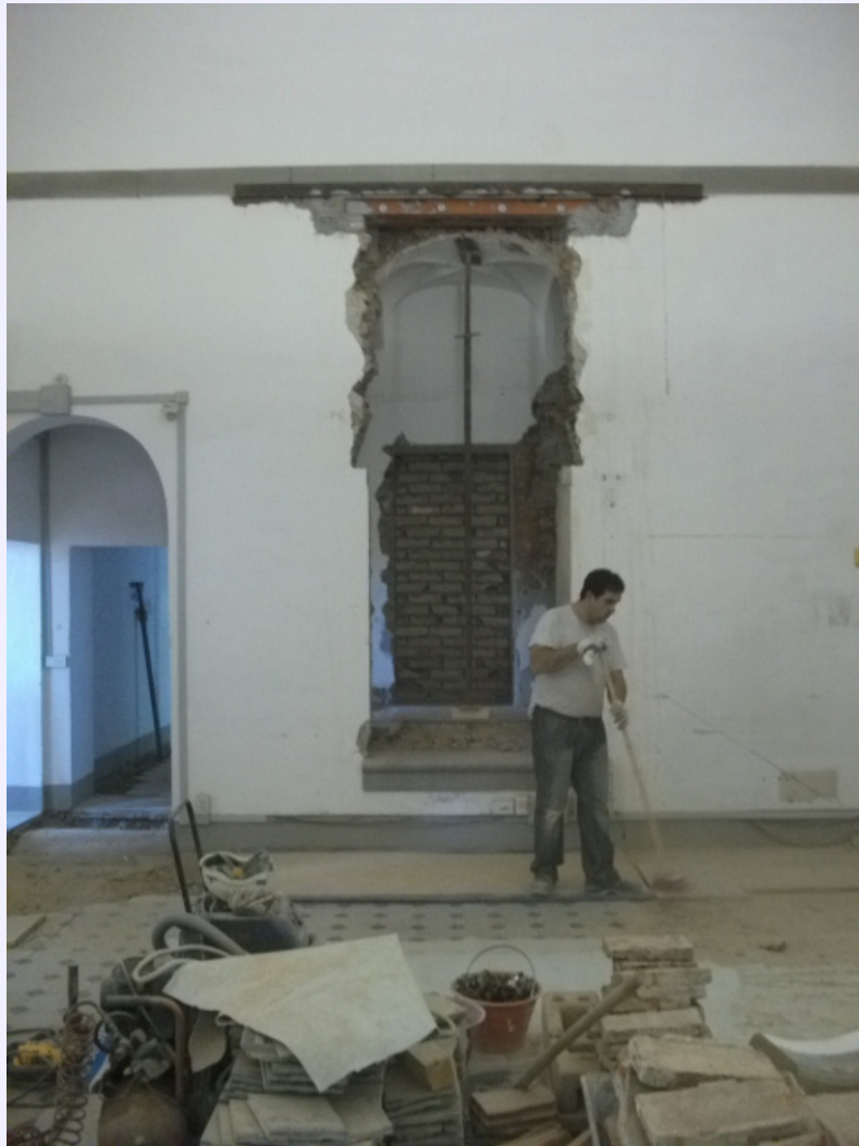
opere strutturali modifica portale
