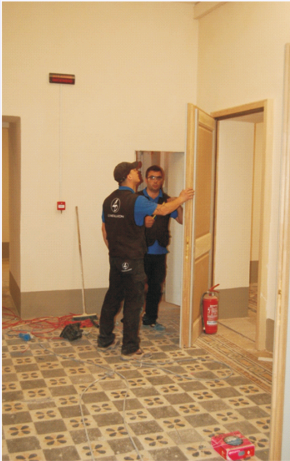
montaggio delle porte in regola con le normative e verniciatura delle stesse
