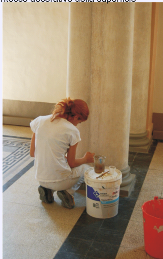
stato di fatto della serliana - dai saggi preliminari si evidenziava il marmorino sottostante fasi di pulitura con impacchi ammorbidenti e raschietti
