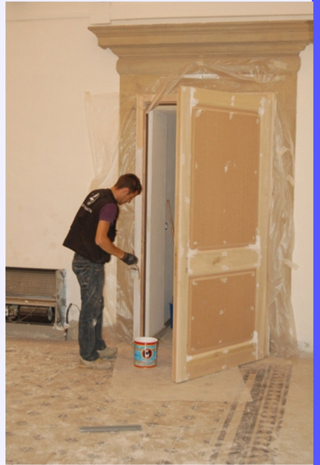
montaggio delle porte in regola con le normative e verniciatura delle stesse
