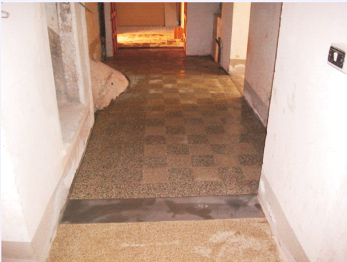
pavimentazione rimontata sul passaggio T 29 e T 30
