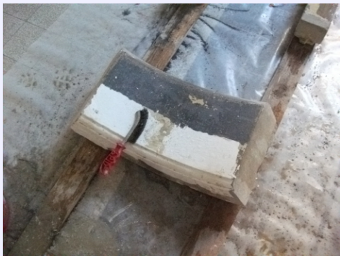
elementi in arenaria del portale interno appena smontati
