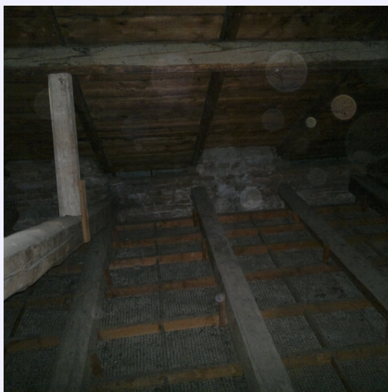
il sottotetto prima dell'intervento
