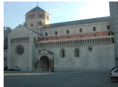
DUOMO Trento Restauro lapideo esterno
