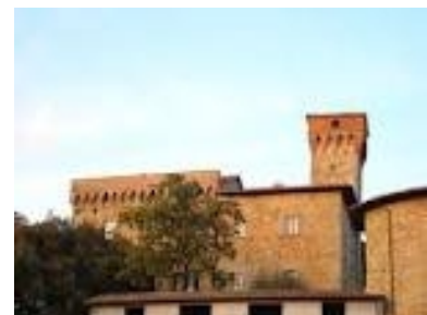
CASTELLO DI LIPPIANO Monte Santa Maria Tiberina (PG) Consolidamento e restauro
