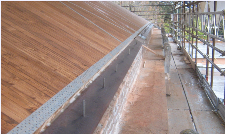
consolidamento del controsoffitto con fibra di vetro impregnata con resina epossidica, questo ha permesso di solidarizzare la struttura in arellato con le travature sovrastanti
