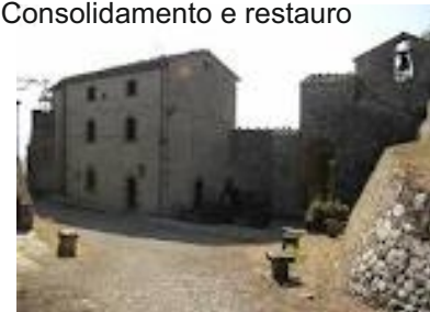
CAPRESE MICHELANGELO (AR) Palazzo Clusini - Casa Natale di Michelangelo Consolidamento e restauro
