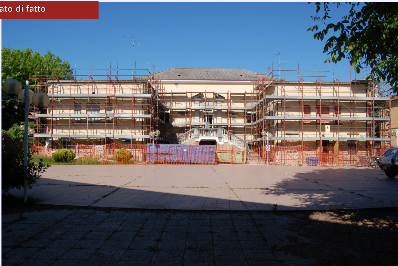
allestimento del cantiere prima del montaggio della copertura provvisoria
