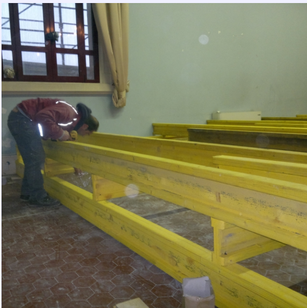
montaggio della struttura del palcoscenico
