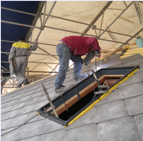
montaggio delle nuove lastre in sostituzione delle vecchi in cemento/amianto
