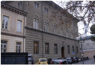
SEDE STORICA CARIM Rimini Restauro lapideo esterno
