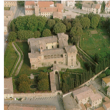
CASTELLO BUFALINI San Giustino (PG) Consolidamento e restauro
