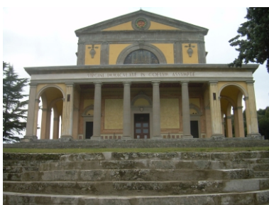
SANTUARIO DI CANOSCIO Città di Castello (PG) Restauro e consolidamento
