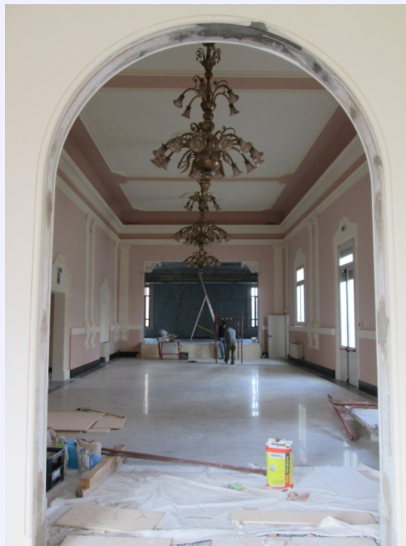
interventi di finitura interna che ridanno nuova luce all'edificio
