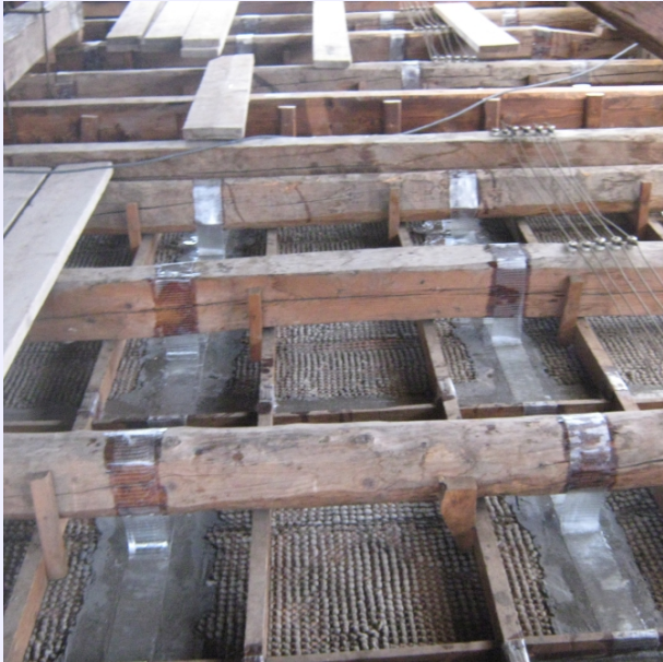
consolidamento del controsoffitto con fibra di vetro impregnata con resina epossidica, questo ha permesso di solidarizzare la struttura in arellato con le travature sovrastanti
