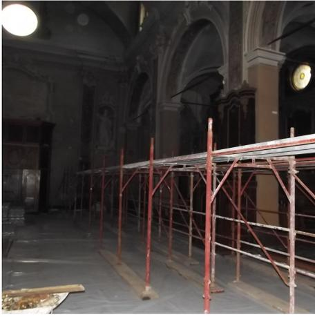
*le fasi di puntellazione della volta per consentire il consolidamento della parte estradossale in sicurezza. la puntellazione è stata realizzata in struttura mista telai e tubo/giunto, l'azione meccanica del piedino è ripartita con tavole longitudinali.*
