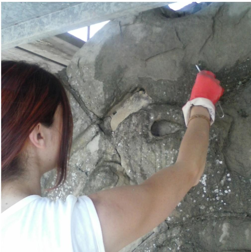
Il fissaggio delle scaglie è stato effettuato con dei ponticelli in resina con il solo scopo di non perdere materiale lapideo.
