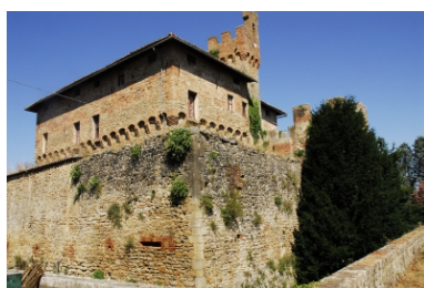
CASTELLO DI BIBBIANO Buonconvento (SI) Restauro e consolidamento
