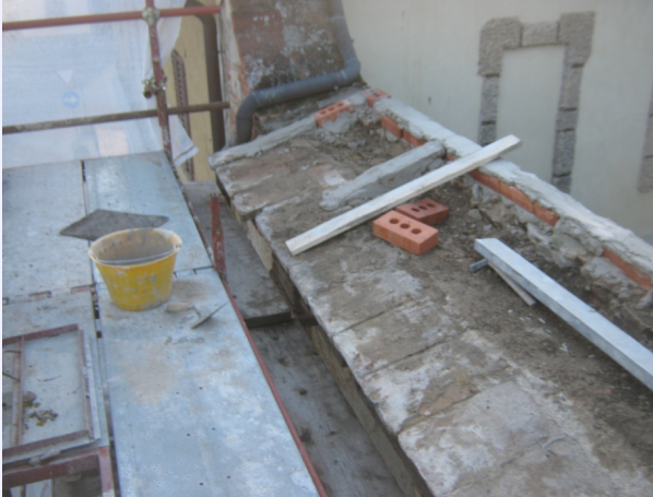
rimozione copertura e materiale incoerente rimosso
