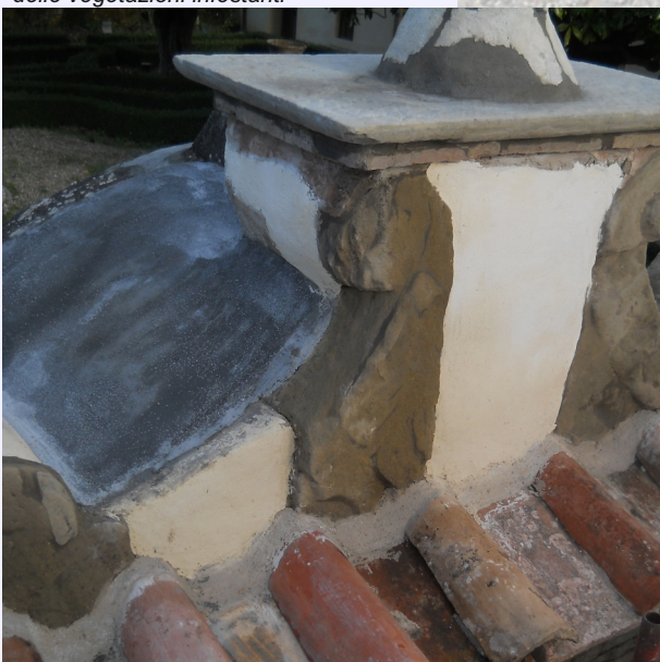
rimontaggio degli elementi dopo la rimozione delle vegetazioni infestanti
