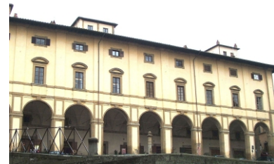
LOGGE VASARIANE Arezzo Restauro e consolidamento
