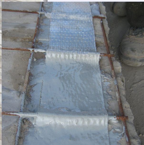
montaggio del manto con materiale di recupero
