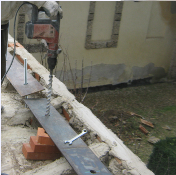
perforazione e posizionamento del profilo in acciaio
