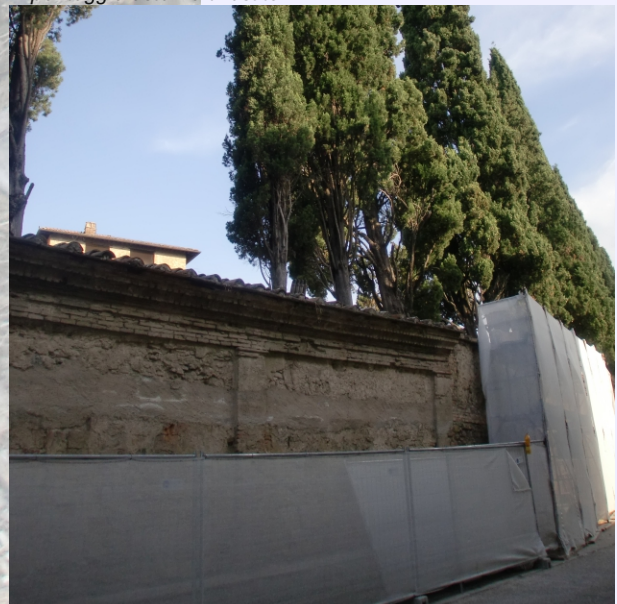
ponteggio esterno allestito
