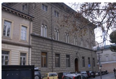
SEDE STORICA CARIM Rimini Restauro lapideo esterno
