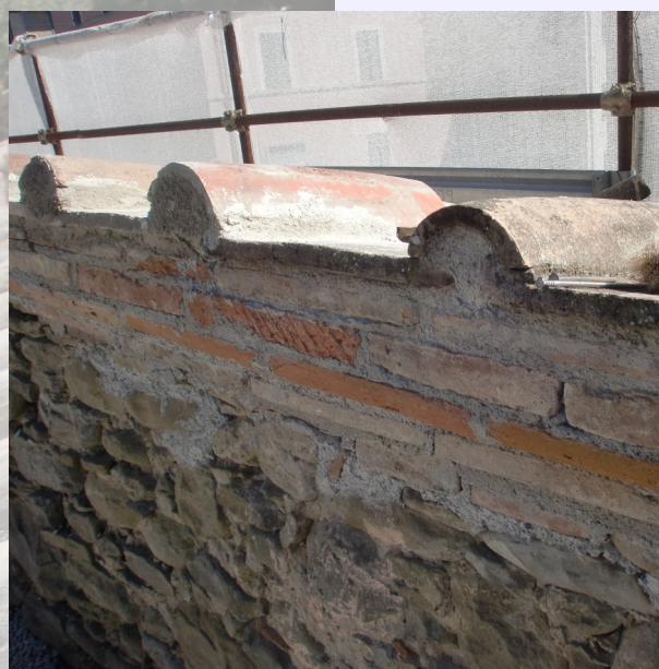
muratura superiore con piatto in acciaio
