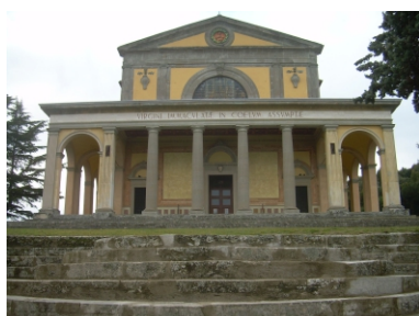
SANTUARIO DI CANOSCIO Città di Castello (PG) Restauro e consolidamento
