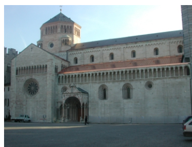
DUOMO Trento Restauro lapideo esterno
