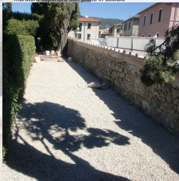
vista finale dell'intervento
