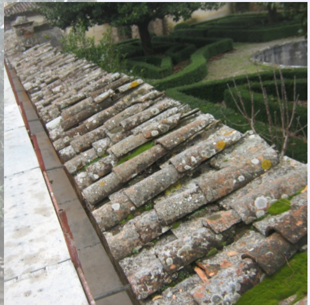
stato di fatto della copertura del muro
