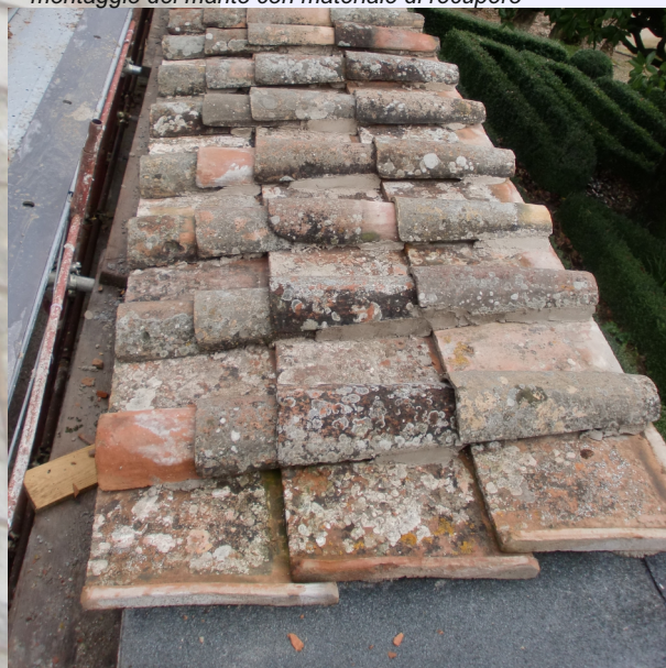
montaggio del manto con materiale di recupero
