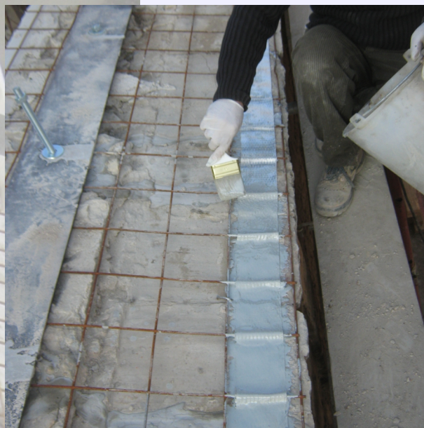
ancoraggio della rete con fibra di vetro e resina epossidica a bassa viscosità al fine di annullare il fenomeno di ribaltamento della gronda
