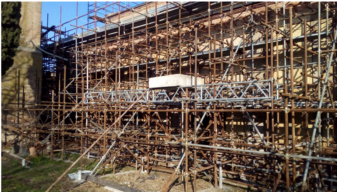
vista del ponteggio lato destro durante le fasi di zavorramento
