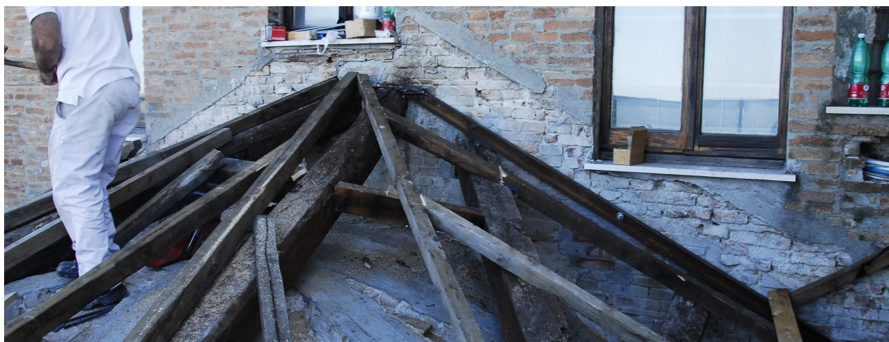
vista della struttura in legno completata, particolare dell'attacco orditura principale e secondaria con angolari in acciaio opportunamente sagomati
