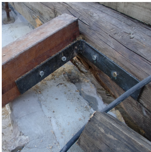
vista della struttura in legno completata, particolare dell'attacco orditura principale e secondaria con angolari in acciaio opportunamente sagomati
