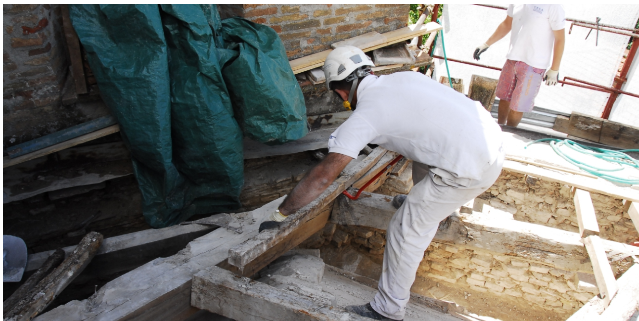
bonifica delle spina con appoggio degradato con inserimento di profilo in acciaio di rinforzo
