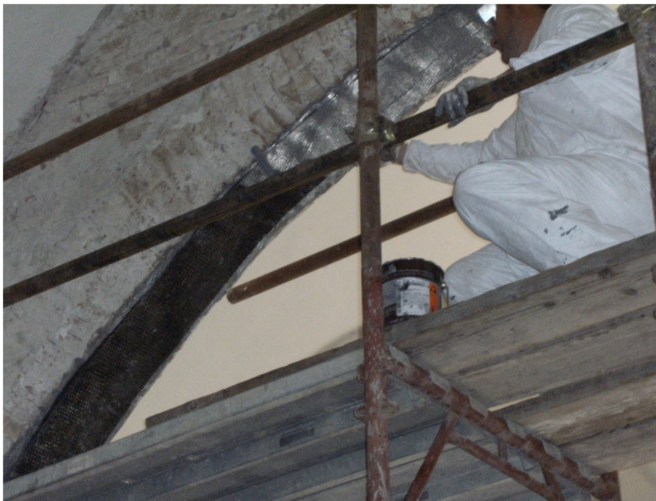
montaggio della fibra in doppio strato all'intradosso dell'arco
