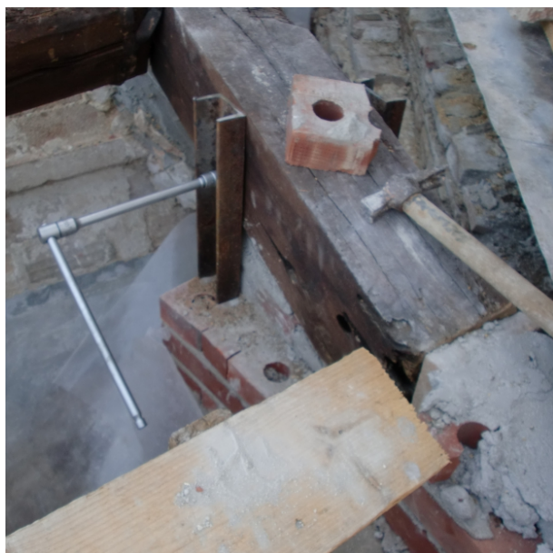
vista della struttura in legno completata, particolare dell'attacco orditura principale e secondaria con angolari in acciaio opportunamente sagomati
