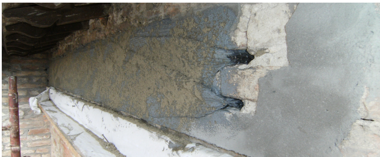
fibra di carbonio montata su rasante in fibrorinforzato, la zona di ancoraggio della fibra viene iniettata con resina epossidica fluida
