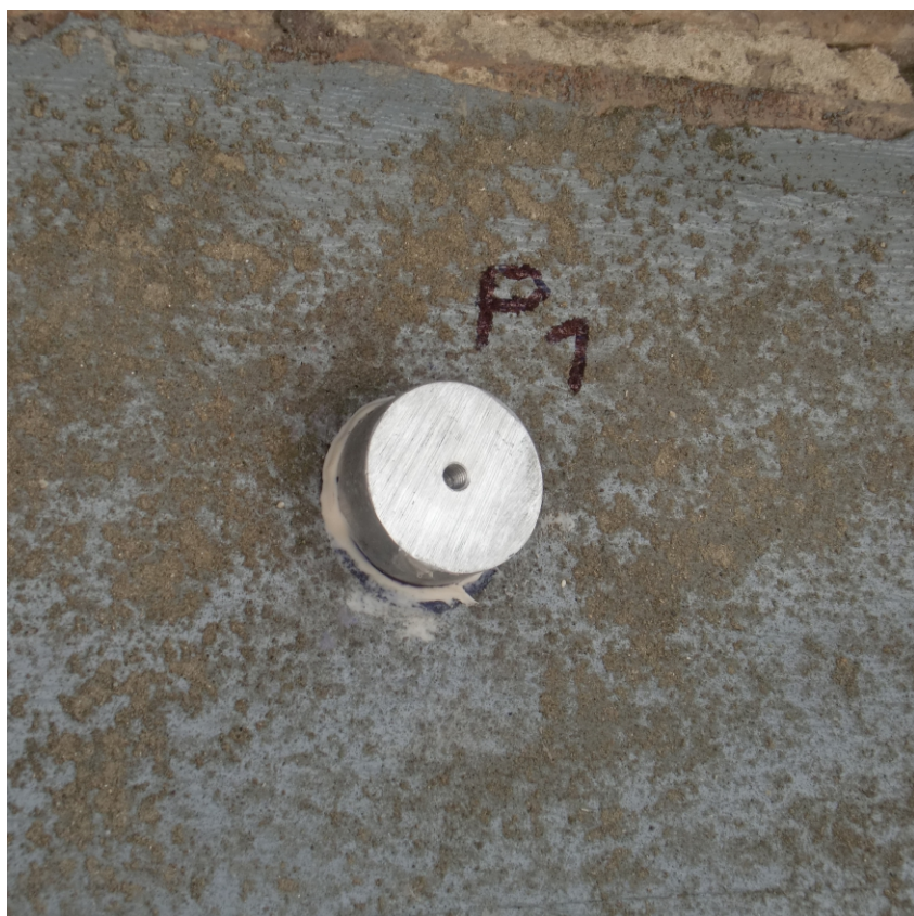
particolare della zona dove viene realizzata la prova di PULL OFF
