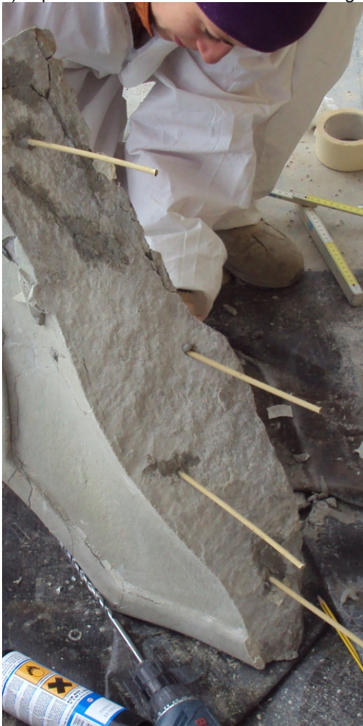
c) impregnatura con barre in aramidico inghisate con resine epossidiche
