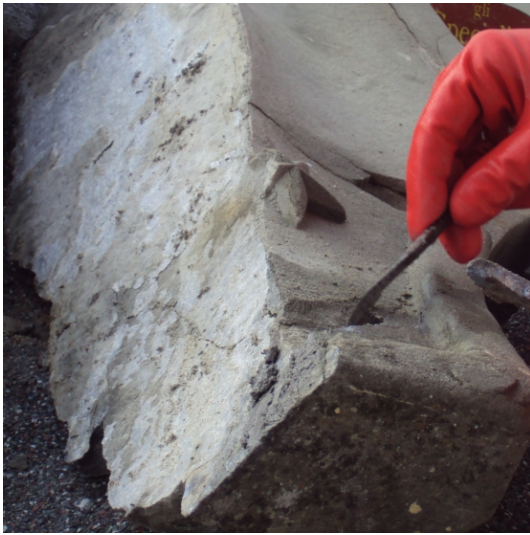
restauro dello stemma della facciata con dettaglio di tutte le fasi operative: a) riadesione delle scaglie b) stuccatura
