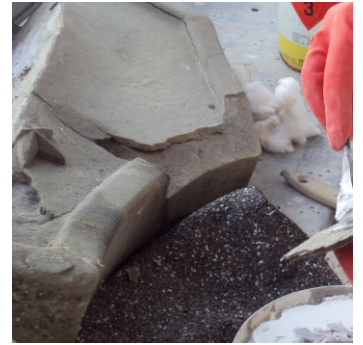
restauro dello stemma della facciata con dettaglio di tutte le fasi operative: a) riadesione delle scaglie b) stuccatura
