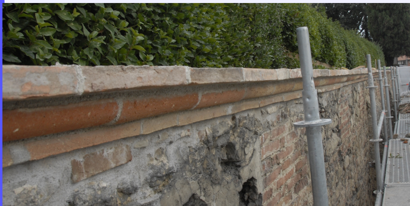
fase 2 montaggio dell'ovolo sagomato in cantiere fase 3 posa del secondo listello a completare la cornice
