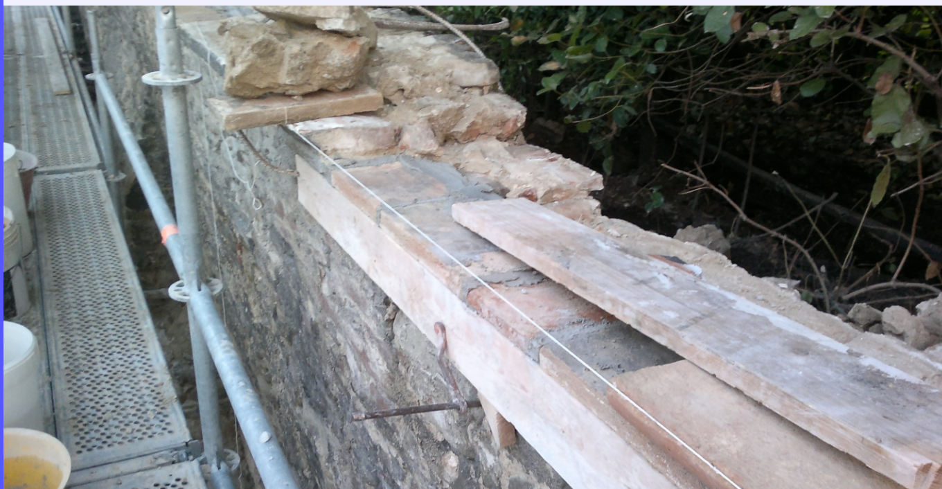
fase 1 rimontaggio del primo listello della cornice
