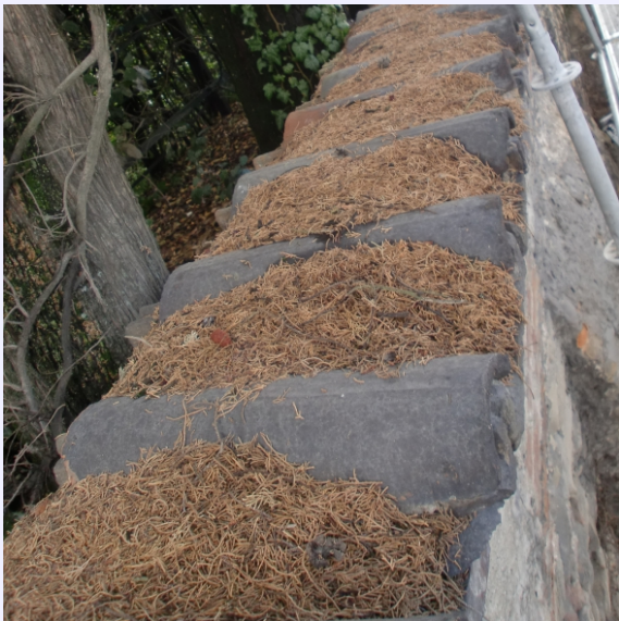
situazione prima dell'intervento
