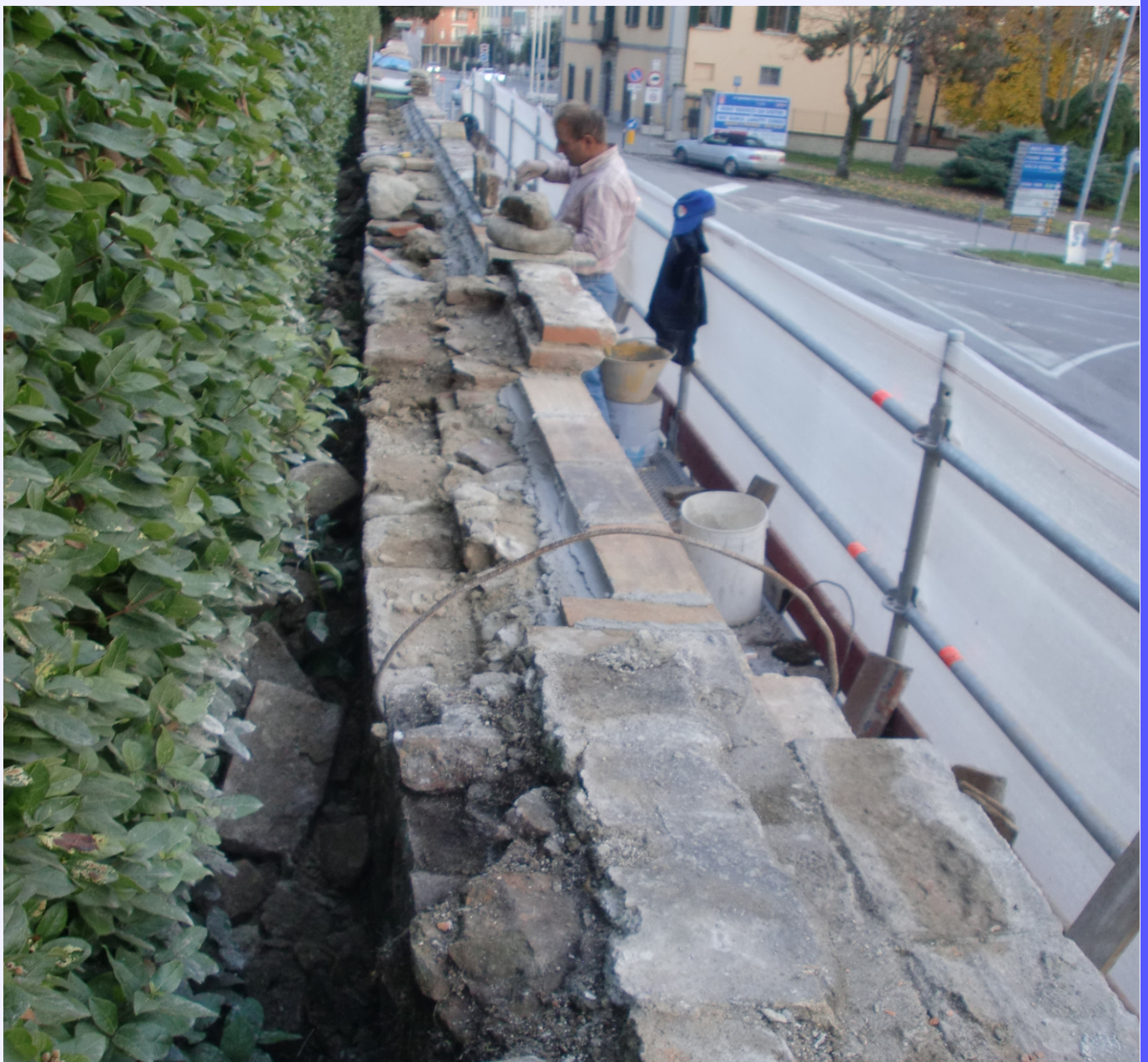
fase di rimontaggio della cornice dopo la rimozione del materiale incoerente
