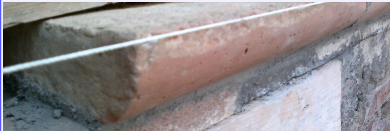
fase 2 montaggio dell'ovolo sagomato in cantiere fase 3 posa del secondo listello a completare la cornice
