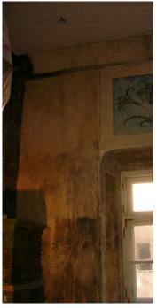
polverosa dello strato e alla presenza delle linee verticali che con ogni probabilità. Questa alterazione con ogni probabilità è dovuta alla azione termica delle stufe.
