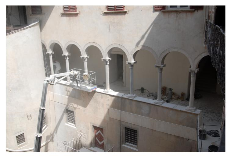
Consolidamento in profondità (maltine) Consolidamento in profondità di intonaci distaccati dal supporto murario e ricollegamento materico dei distacchi dell'intonaco pittorico all'arriccio a mezzo di iniezioni di maltine adesive e collanti.
