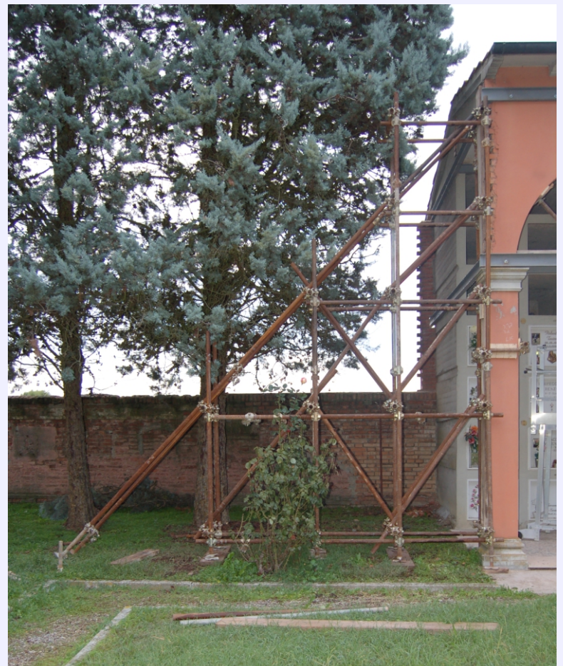
particolare delle fasi di montaggio dei profili in acciaio che contengono la spinta degli archi e sostengono la puntellazione degli stessi
