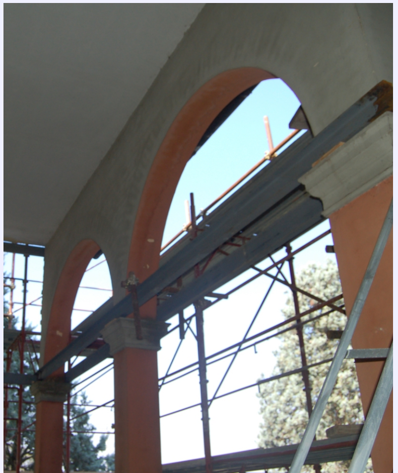
particolare delle fasi di montaggio dei profili in acciaio che contengono la spinta degli archi e sostengono la puntellazione degli stessi
