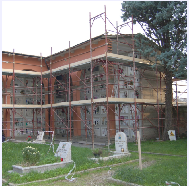
fase di allestimento del ponteggio
