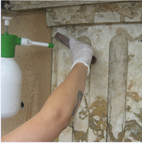
pulitura con acqua demineralizzata
