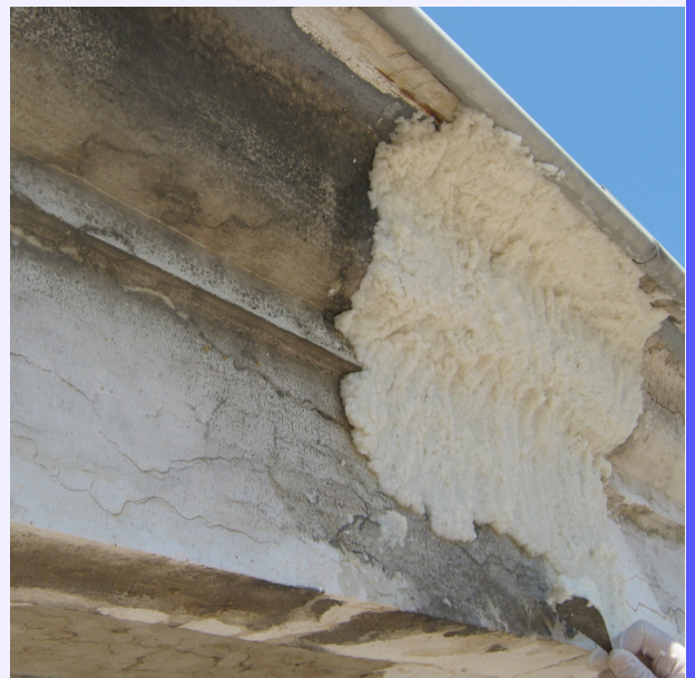
durante l'applicazione dell'impacco
