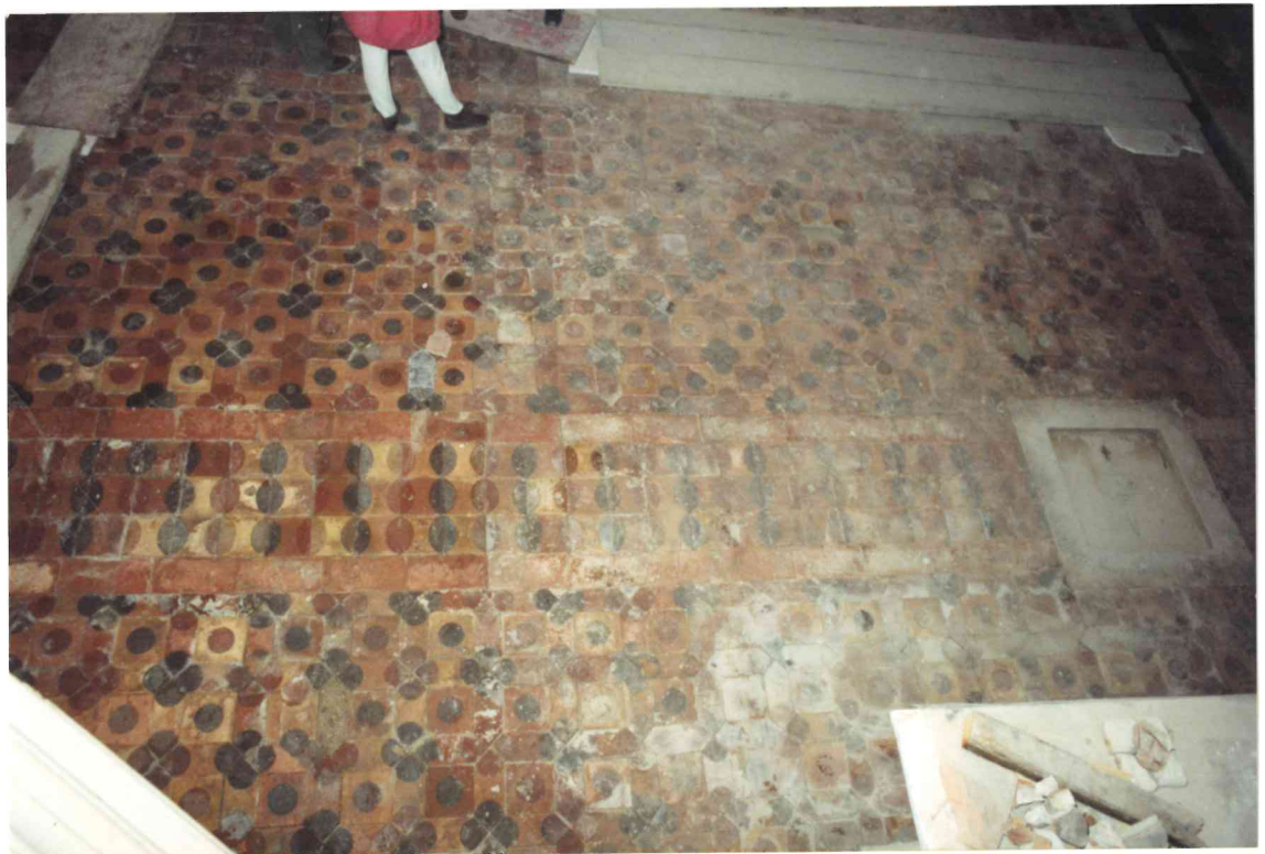
Visione d'insieme dell'intervento dopo il rimontaggio
