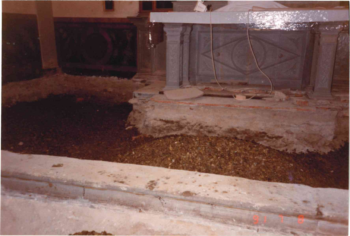
RIMOZIONE PAVIMENTO CREAZIONE MASSETTO
