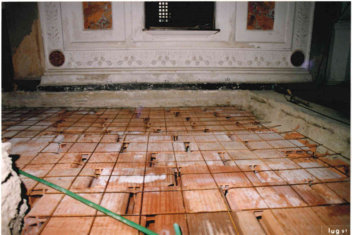
POSATURA PIGNATTE E RETE ELETTRO SALDATA
