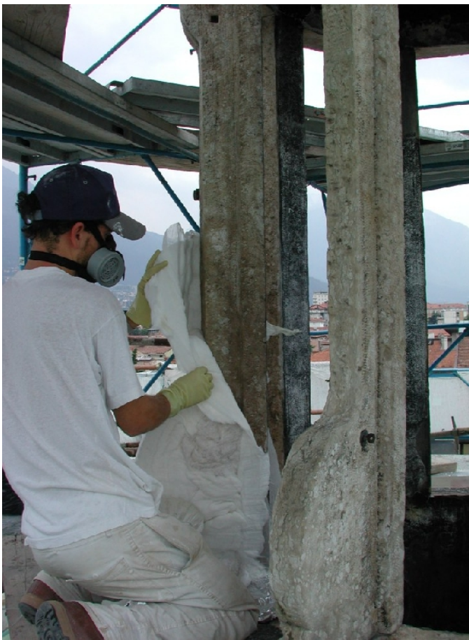
Sopra e sotto: due momenti durante il consolidamento dei montanti della lanterna della cappella del S.S. Crocefisso. Tale intervento è stato eseguito mediante impacco e percolazione di RC 80 (Rhoximat), fino a rifiuto
