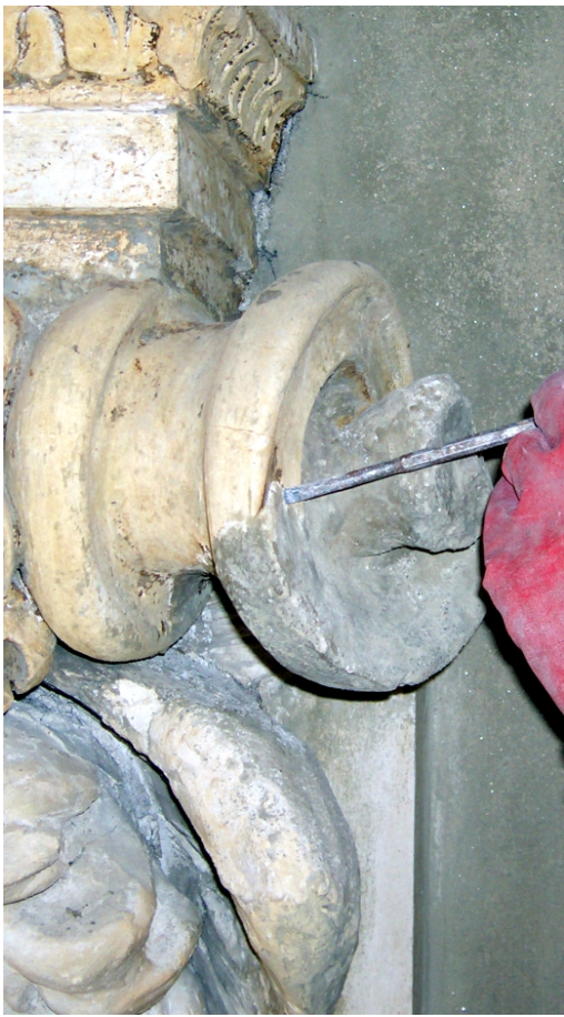
Modanato architettonico dopo la pulitura prima del ritocco
