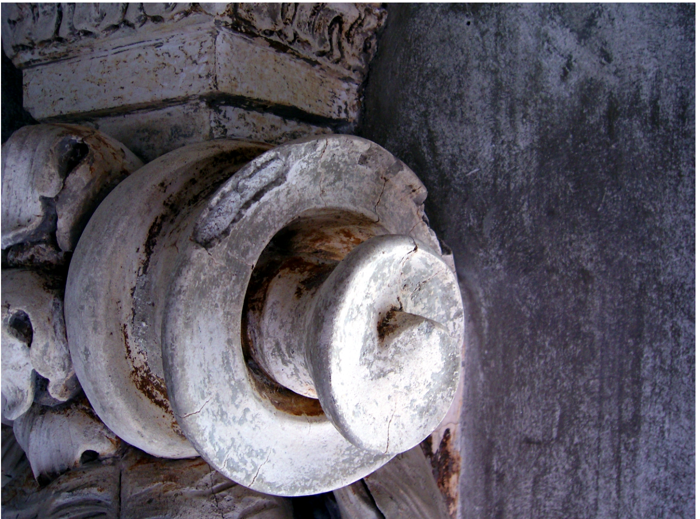
Modanato architettonico dopo la pulitura prima del ritocco
