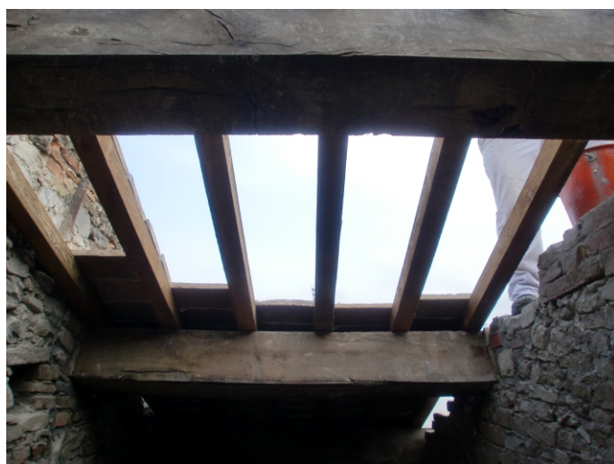
montaggio della grossa orditura
