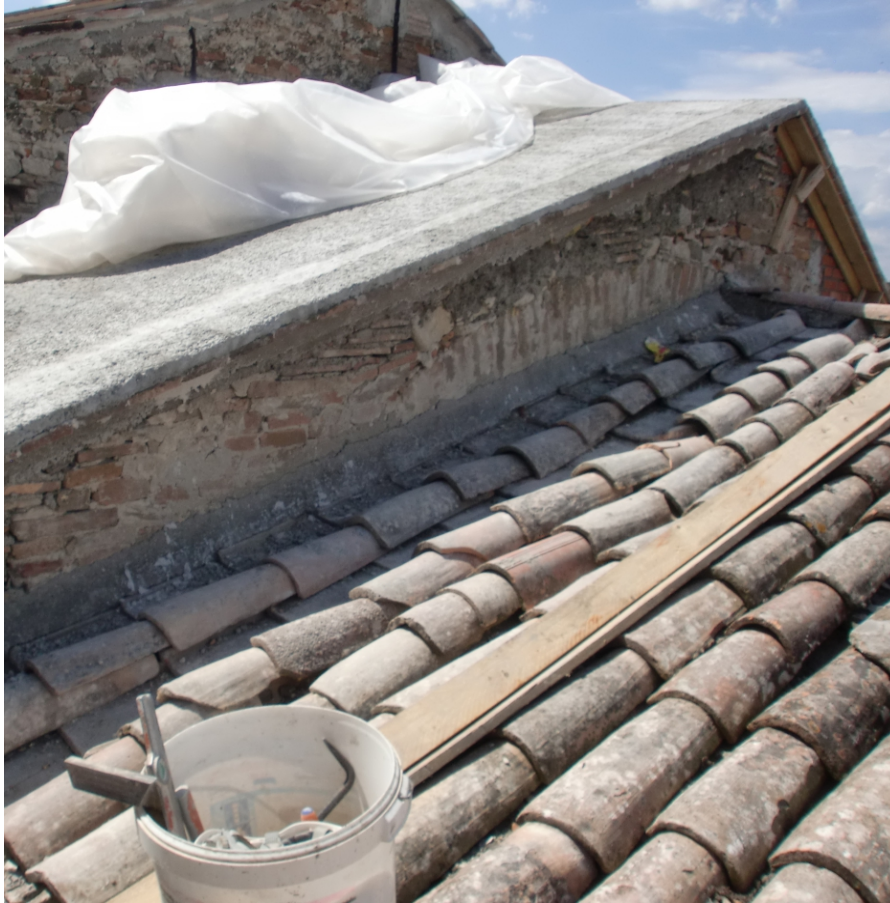
vista della soletta in calcestruzzo prima del montaggio della guaina
