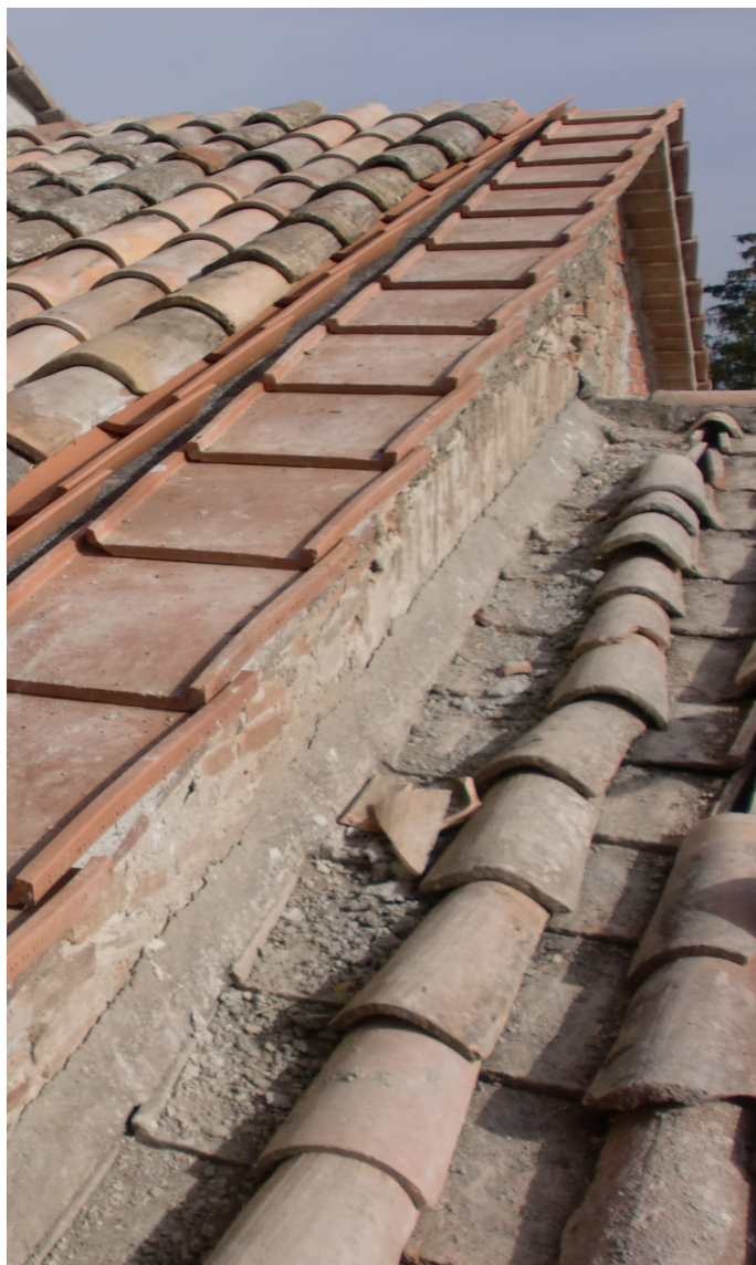
dettaglio del compluvio dopo la posa della conversa in rame
