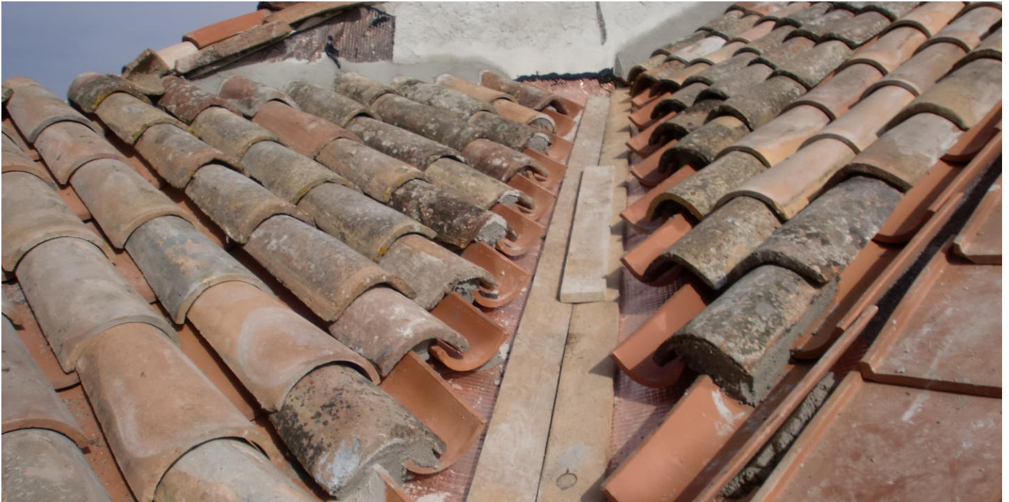
dettaglio del compluvio dopo la posa della conversa in rame
