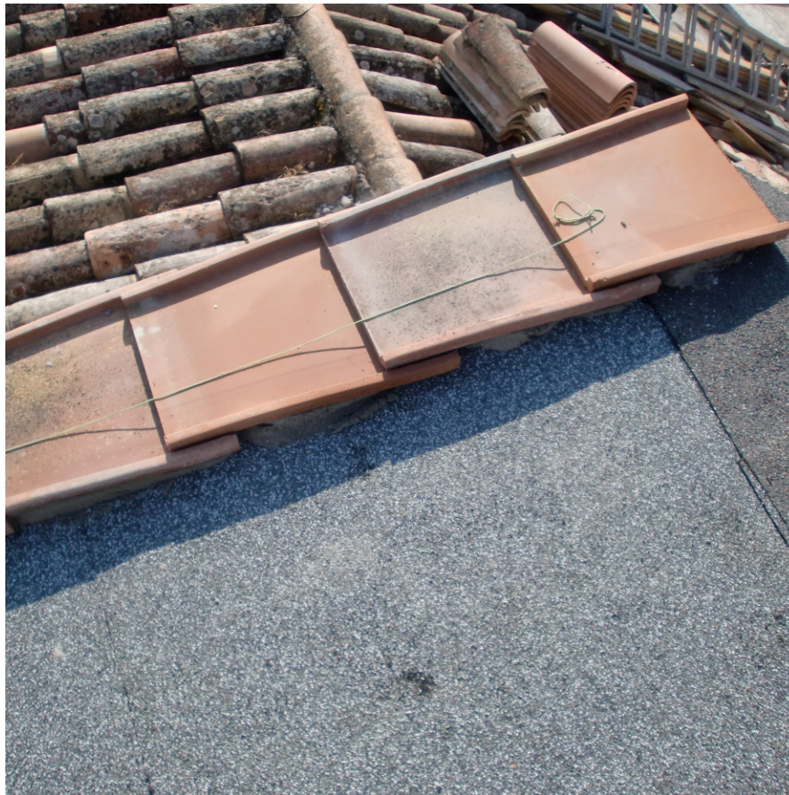
inizio del montaggio del malto particolare della tegola di bordo vista della copertura prima del montaggio dei coppi
