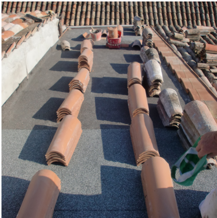
inizio del montaggio del malto particolare della tegola di bordo vista della copertura prima del montaggio dei coppi
