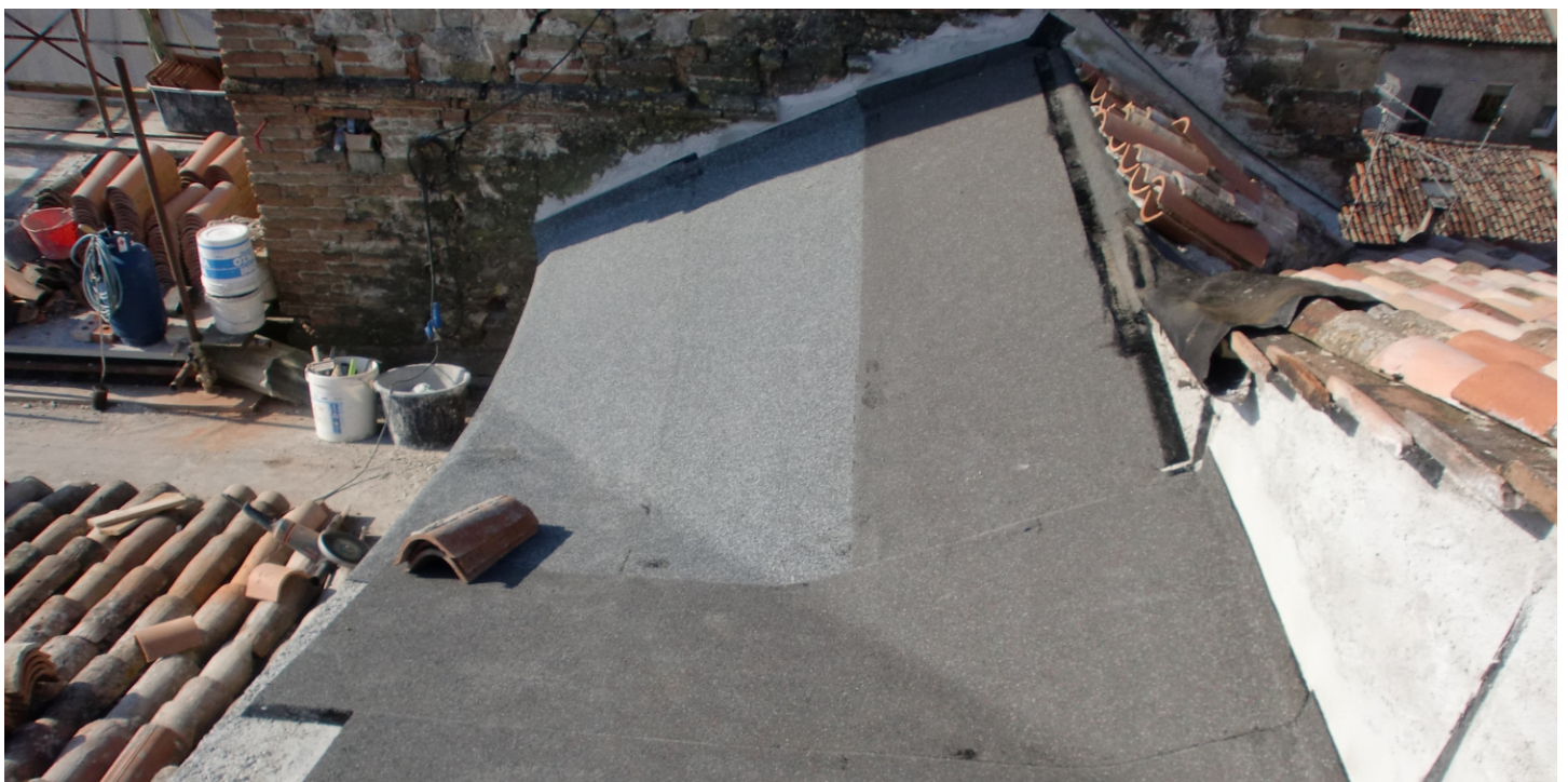
copertura a guaina montata nel dettaglio del compluvio
