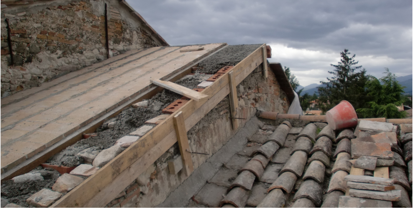
montaggio del pianellato e preparazione cassaforma per il montaggio della gronda
