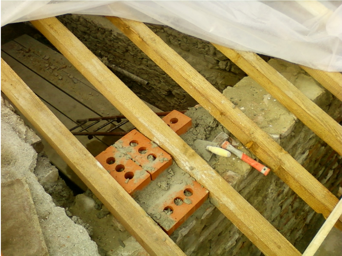
piccola orditura montaggio e chiusura degli spazi con mattoni pieni
