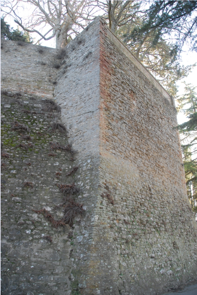
Parte muraria bastione centrale prima dell'intervento con particolare esecutivo di rafforzamento con tiranti metallici, pali di sottofondazione e travi di coronamento in cemento armato;
