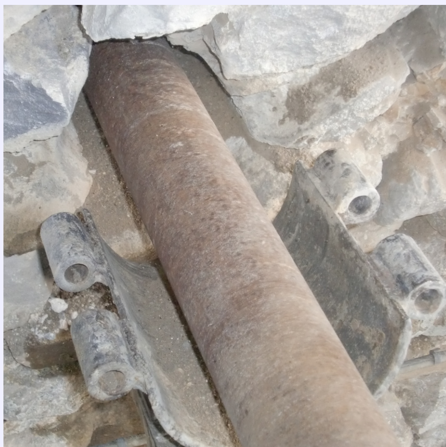
Pulizia interna del foro con l'utilizzo di aria compressa per permettere l'inserimento delle barre ;
