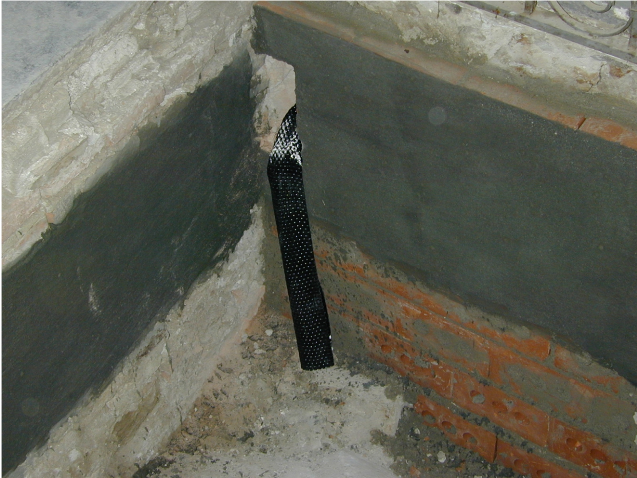
Sistema di ancoraggio tra elementi in composito posti ad angolo retto tra loro
