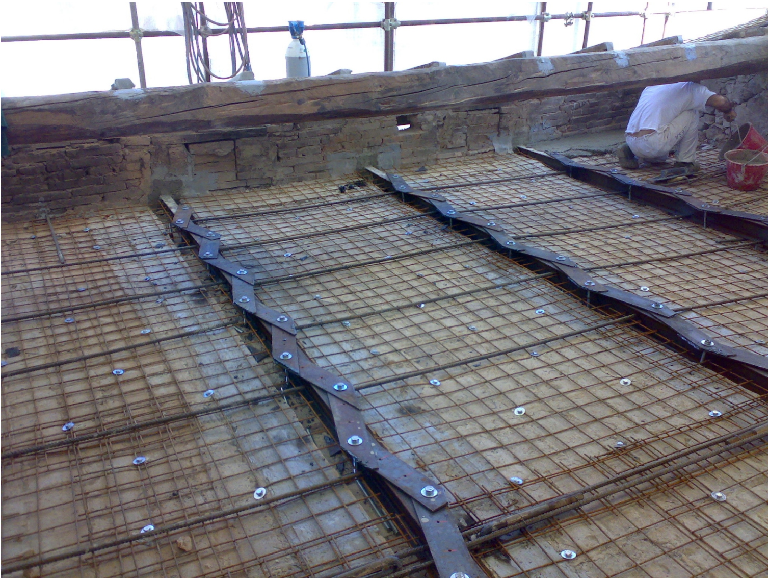
Sistema di consolidamento della trave decorata con chiodature a quinconce infisse nel legno e collegate con piatto in acciaio a losanghe
