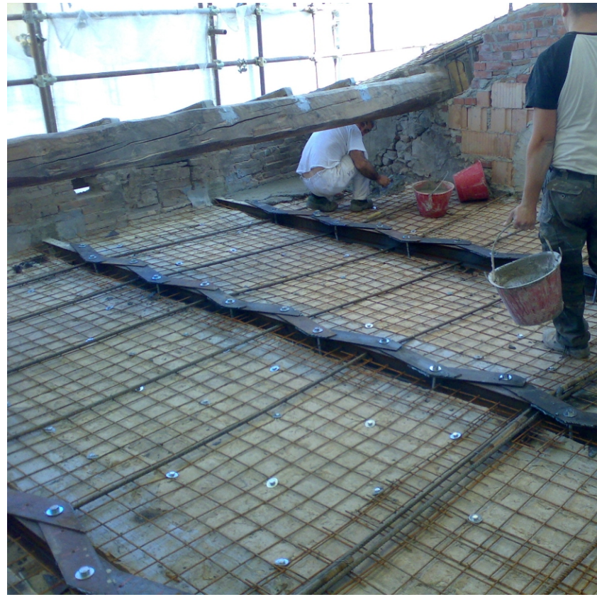
Il momento flettente viene completamente supportato dalla trave a doppio T posta all'estradosso
