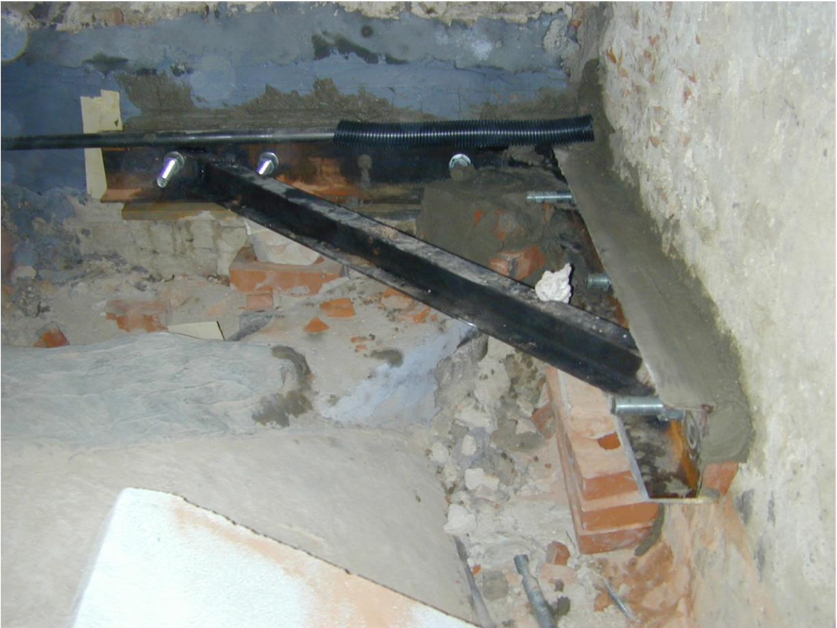
Sistema di ancoraggio tra elementi in composito posti ad angolo retto tra loro
