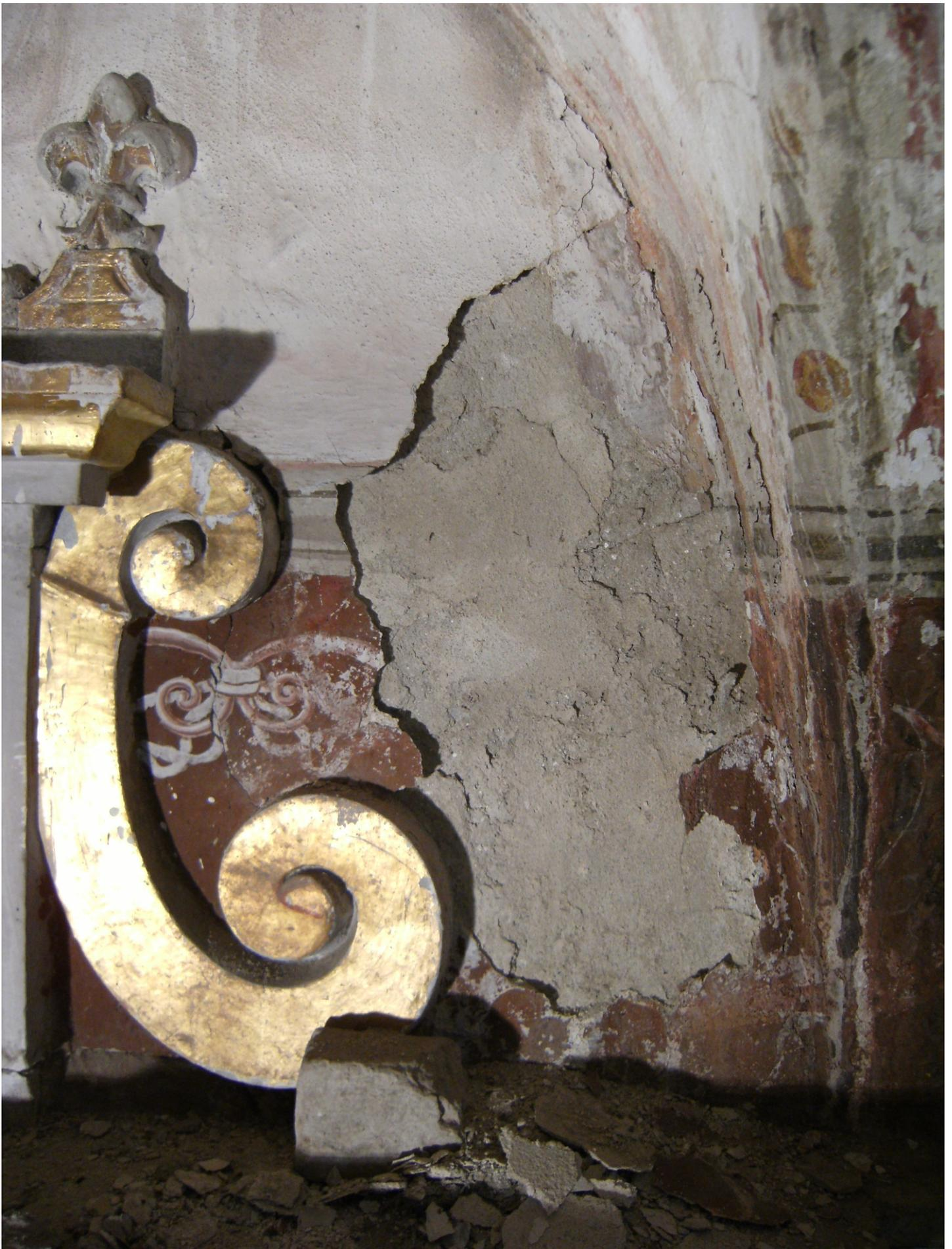
Particolare dell'appoggio della volta dove l'infiltrazione di acqua meteorica ha degradato tutta la superficie degli intonaci
