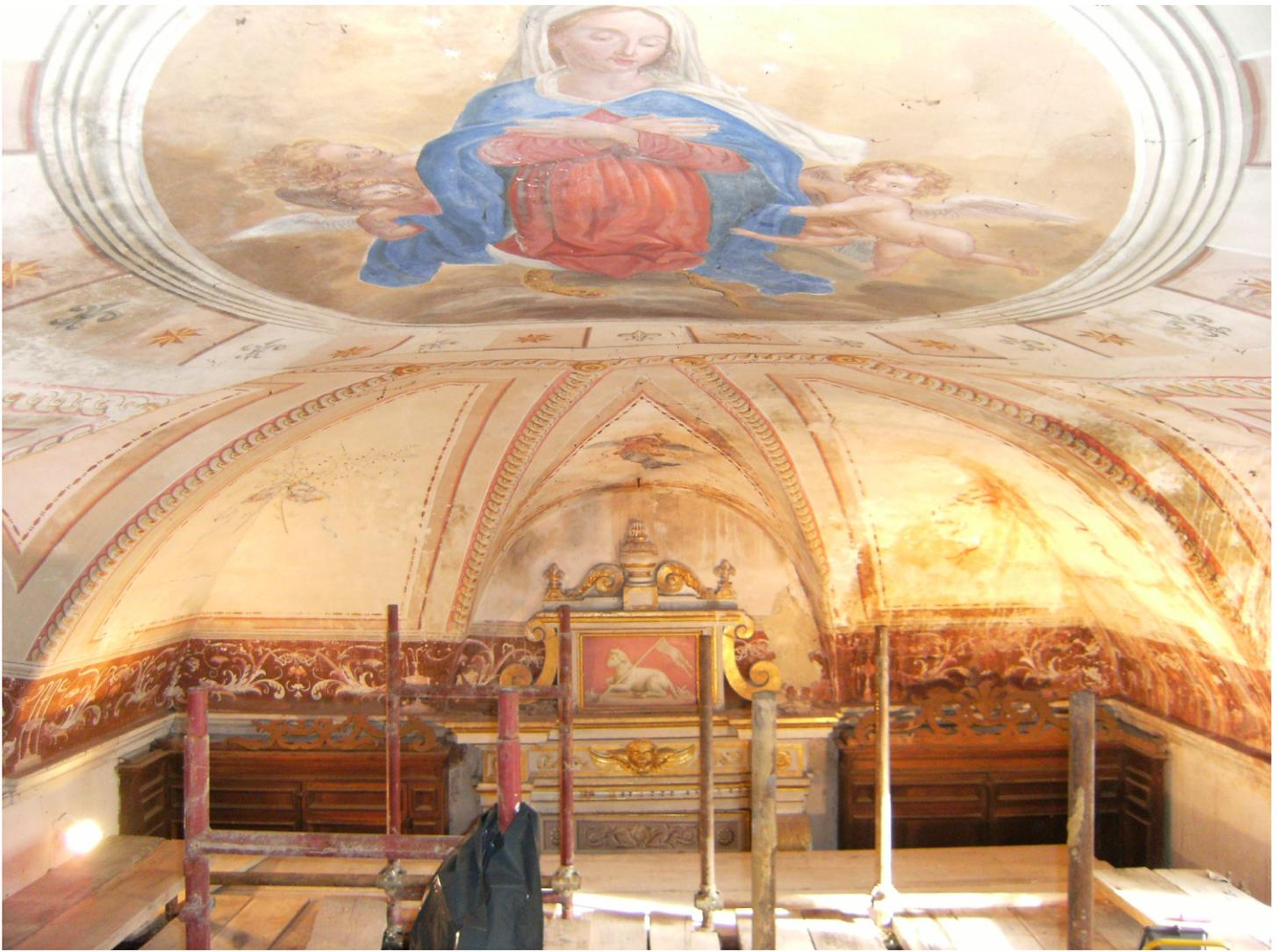
Vista della volta da puntellare a ponteggio montato, la fatiscenza ed il degrado delle superfici è ben evidente
