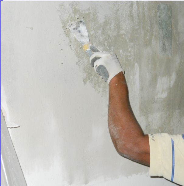
tinteggiatura delle pareti vista del cantiere durante le lavorazioni
