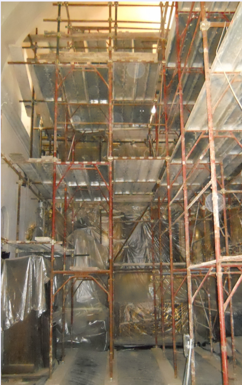
i ponteggi sono stati allestiti con molta cura in quanto le macchine d'altare sono rimaste in opera e protette accuratamente
