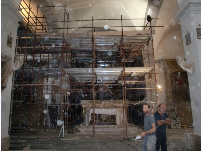
allestimento del cantiere
